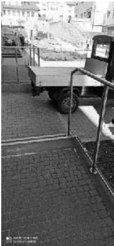
Zdjęcie 4. Czarnobiała fotografia schodów prowadzących do budynku B – widoczne kontrasty koloru na stopniach.
